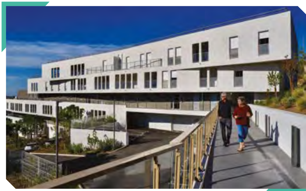
Résidence Saint Augustin, à Carnoux-en-Provence.
