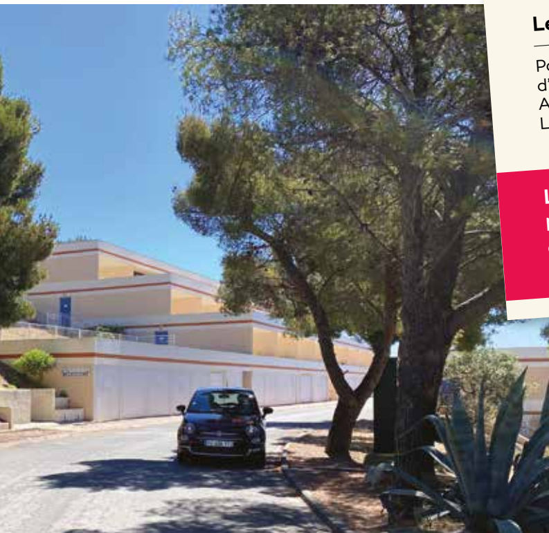
Le Bosquet, à Bandol, accueille la première opération BRS d'Unicil, qui est également la première opération BRS sur de l'existant de la Région.
